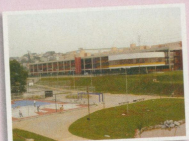
BUTANTÃ - Distrito: Raposo Tavares Plano de Obras 2002 CEU Butantã (obras em fase final) Avenida Engenheiro Heitor Ant. E. Garcia
