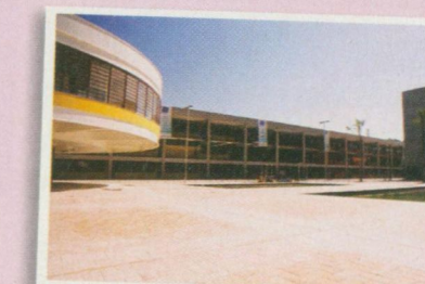
PERUS - Distrito: Perus Plano de Obras 2002 CEU Perus (concluído) Rua Bernardo José de Lorena X Praça Inácio Dias
