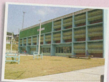
CAMPO LIMPO - Distrito: C. Redondo Plano de Obras 2001 EMEF Cohab Valo Velho (concluída) Rua Cantorias Paulistas
