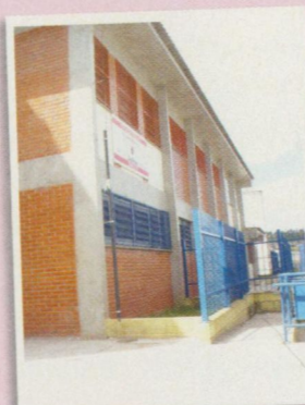
CIDADE TIRADENTES - Distrito: Cidade Tiradentes Plano de Obras 2002 CEI Santa Etelvina IV A (concluída) Av. dos Gráficos X Rua José Araújo Plácido
