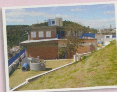
CIDADE TIRADENTES - Distrito: Cidade Tiradentes Plano de Obras 2002 CEI Santa Etelvina V A (concluída) Rua Edmundo Oriolli - L 06 - Q 13D
