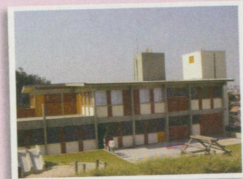
CAMPO LIMPO - Distrito: C. Redondo Plano de Obras 2002 CEI Cohab Adventista I (concluída) Rua da Safra
